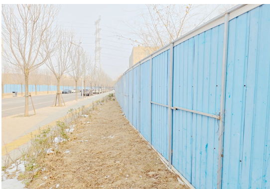
项目北侧围挡
