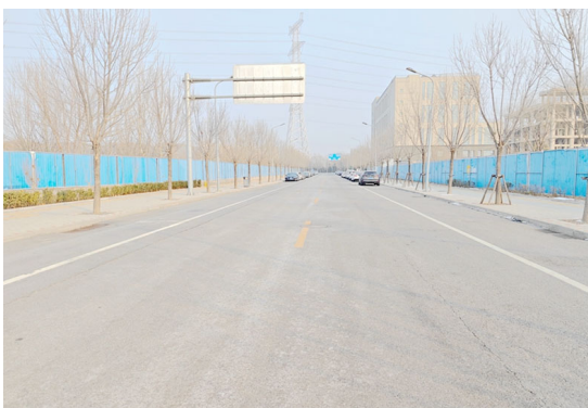
项目北侧现状道路
