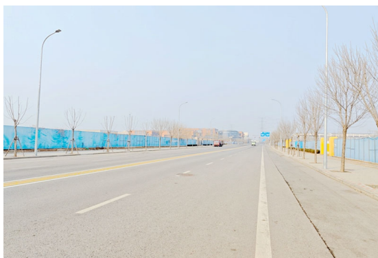
项目西侧现状道路
