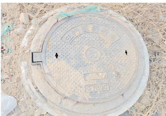
项目内市政下水预留口
